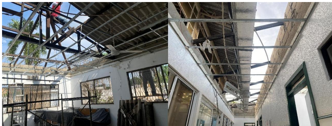
Imagen 4 Desmante de Cubierta en mal estado
