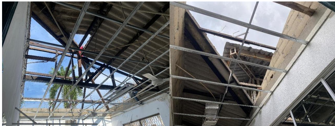
Imagen 4 Desmante de Cubierta en mal estado
